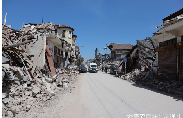
地震で崩壊した通り
